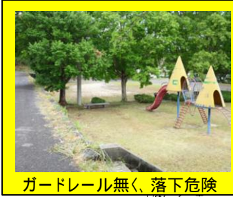
ガードレール無く、落下危険
