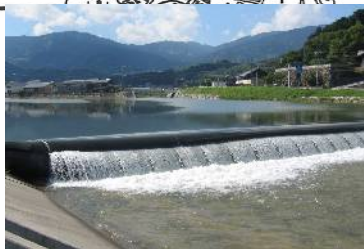
⑨玉島川堰。深みあり。開 門時、急な増水あり。
