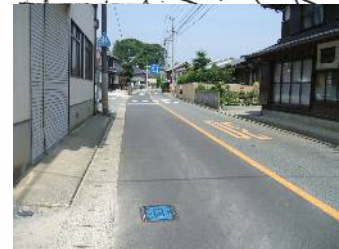
⑧歩道がなく路側帯も狭い
