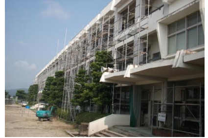
7/27~ 校舎耐震補強工事
